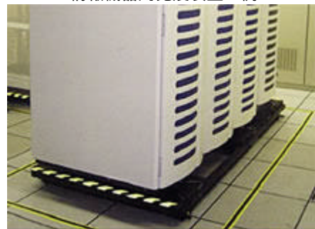
情報機器用免震装置の例
