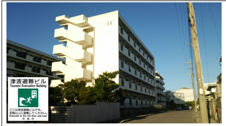
石垣住宅 11 号棟外観
