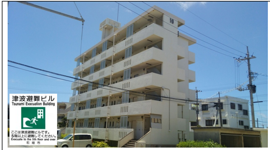
石垣住宅 10 号棟外観
