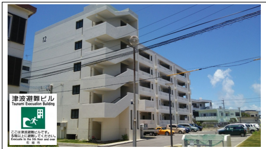
石垣住宅 12 号棟外観
