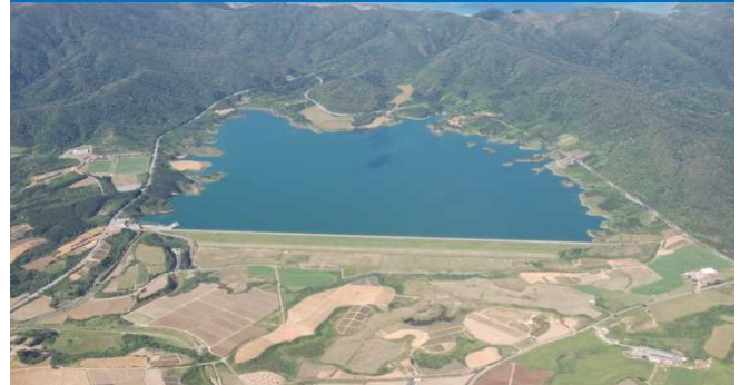
国営かんがい排水事業 底原ダム
