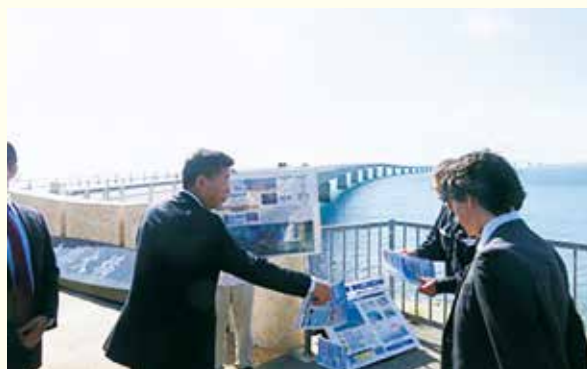
伊良部大橋（宮古島市側）
