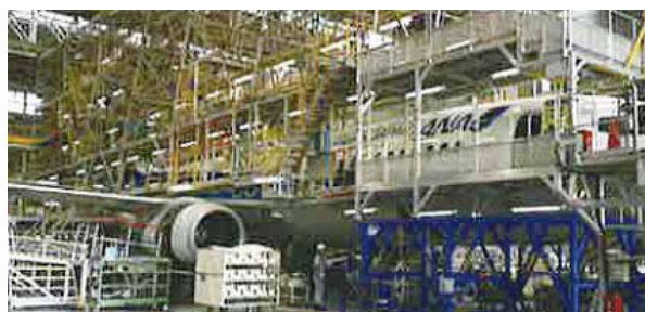
▲ 機体整備の様子(MRO Japan社 伊丹格納庫)
