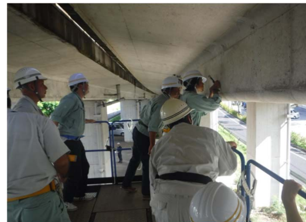
現地点検訓練
